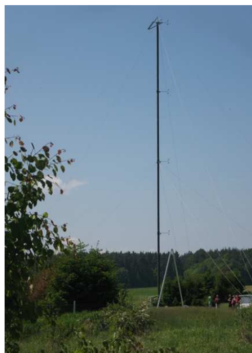
Obr. 2. Realizovaná měřicí stanice
